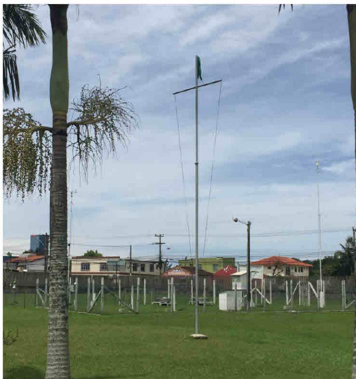
Foto 6: Construção do Mastro
