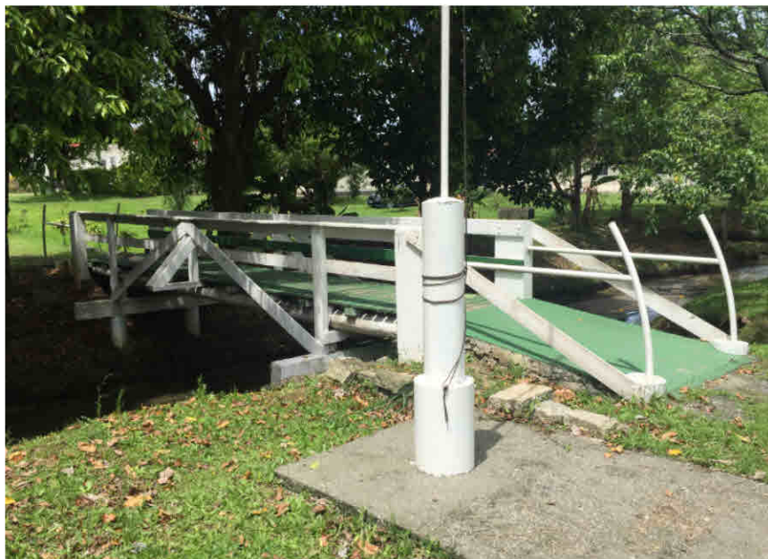
Foto 2: Depois da construção da ponte.
